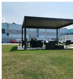
Sede Operativa Swegon Conserve (PD)
