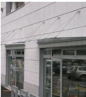
Edificio Piove di Sacco
